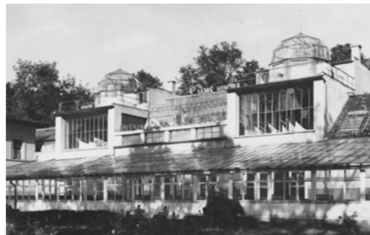
Jihozápadní fasáda Slunečních lázní po přístavbě prosklené verandy architektem Zdeňkem Hoffmanem (1931)
