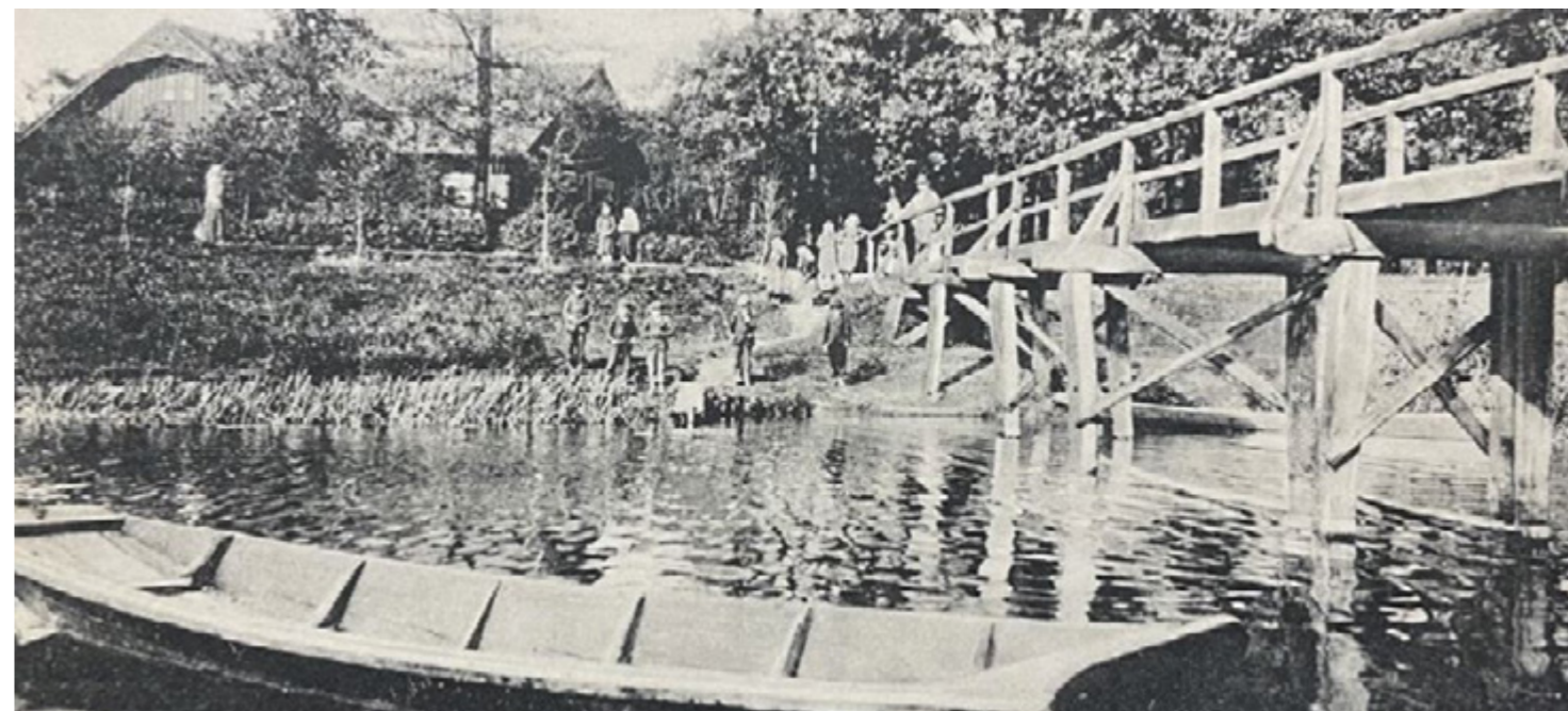
Dřevěný most přes tůň na Starém Labi (1904)
