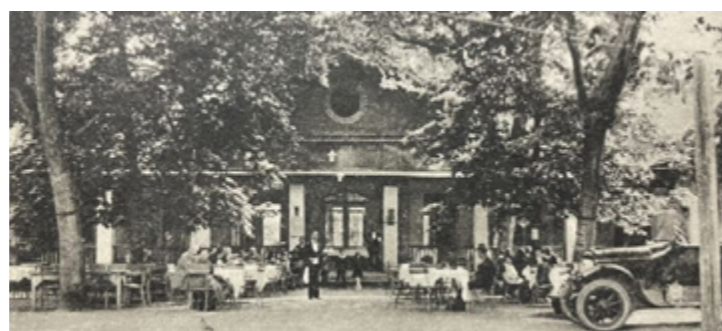
Jižní budova lázní s lázeňskou restaurací postavená stavitelem Karlem Láblérem (1867)
